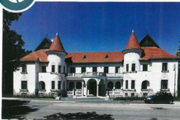
Tudabánya legszebb, 2009-ben műemlékké nyilvánított épülete visszanyerte eredeti formáját
