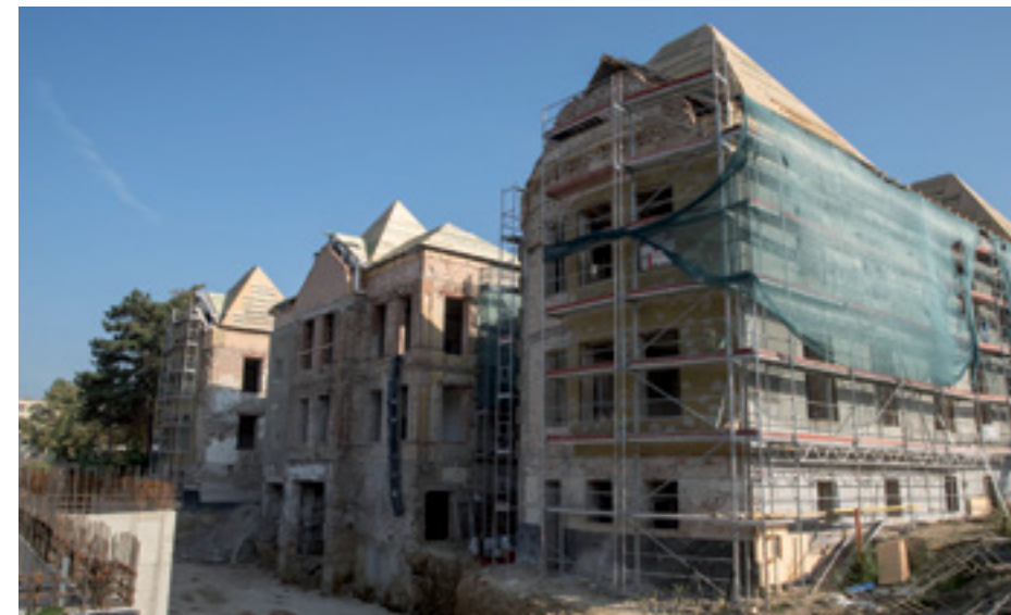
Folytatódhat a tornacsarnok, a közmű-csatlakozások, belső utak és parkolók, udvari tornapályák megépítése.
