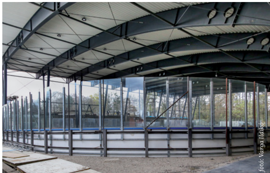
Az I-es ütem építkezése az íves acéltetővel 2016-ban készült el.
