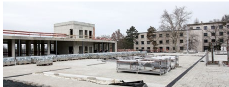
Hamarosan elkezdik a tér felőli oldalon az ún., függőnyfal beépítését az üvegfelületekkel, nyílászárókkal.
