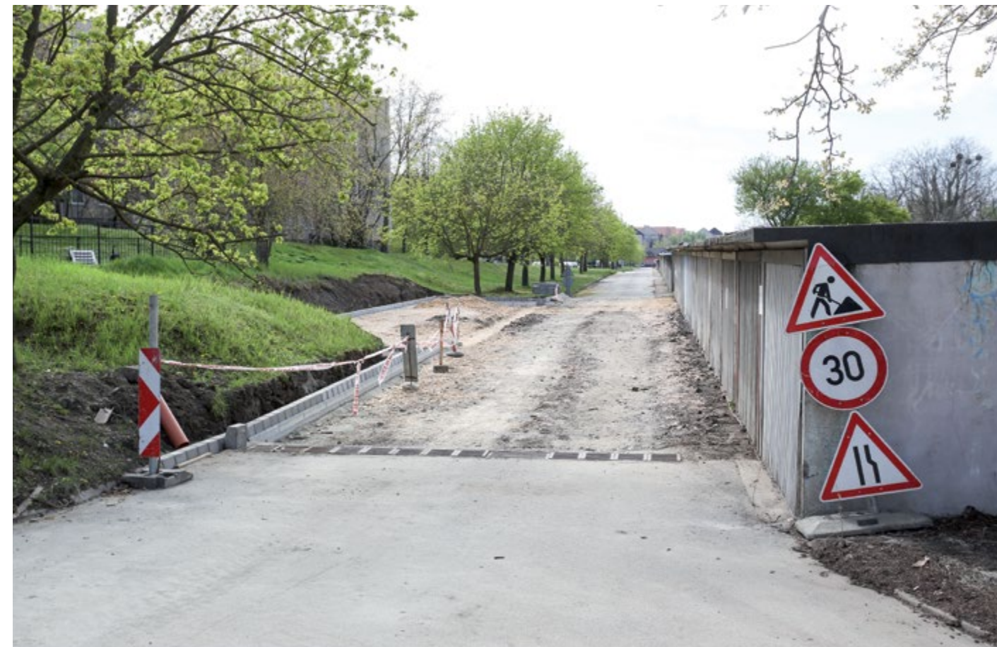
A Gál István lakótelepen a vasút melletti Béke úti garázsor útburkolat egy részének felújítása és csapadékvíz elvezetése is megoldódik nyárig.
